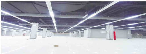
潍坊上城国际超市项目 Weifang Shangcheng International Supermarket Project
