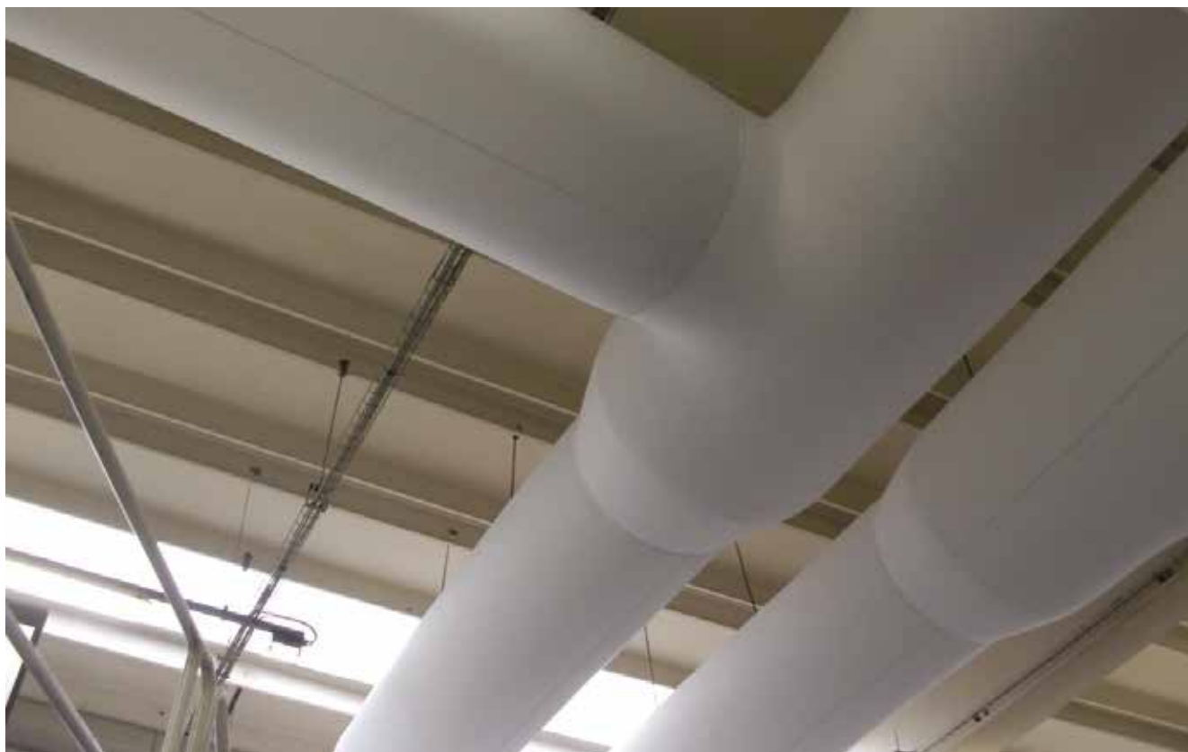
Tee pour gaine DHI TEXTILE DHI TEXTILE diffuser Tee
