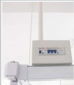
照箱控制箱 (照箱+配电) Control Box(Lighting + Power)
