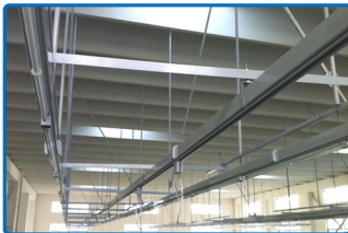
铝合金裁剪母线 Al Alloy Trolley Busbar
