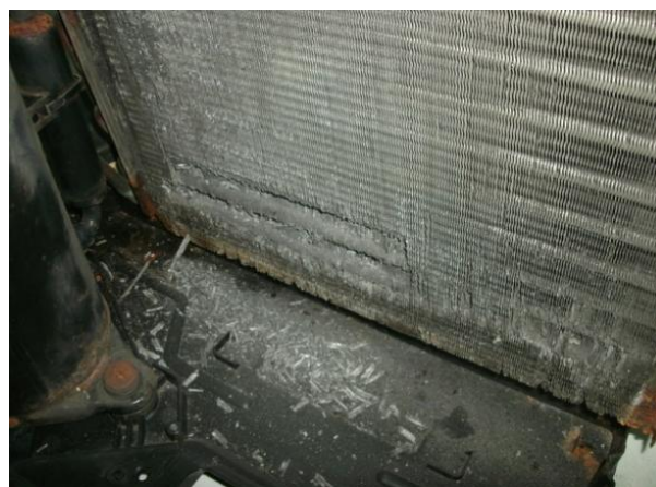
Hình: Dàn trao đổi nhiệt của máy lạnh bị ăn mòn do hóa chất và muối biển
